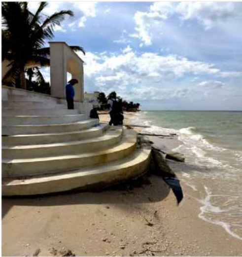
Figura 1. Fuertes problemas de erosión en playas de Yucatán, por la construcción mal ubicada directamente sobre la playa, la remoción de vegetación y dunas, así como problemas regionales de erosión. Fotografía: C. Maximiliano.
