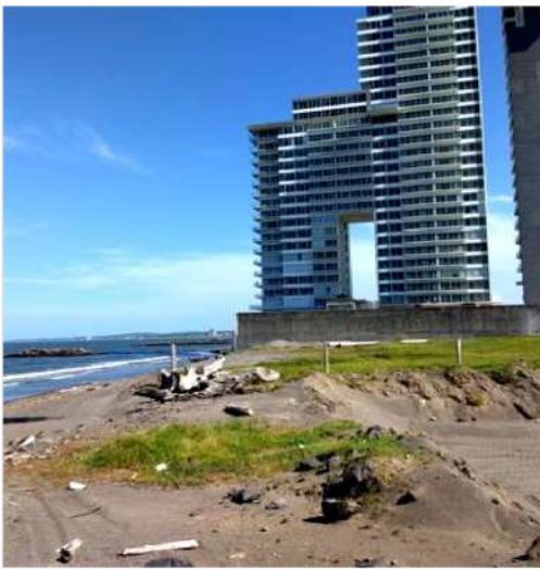
Figura 2. Ejemplo de construcción sobre la playa y el riesgo frente al impacto de oleaje, en el Puerto de Veracruz. Fotografía: C. Maximiliano.
