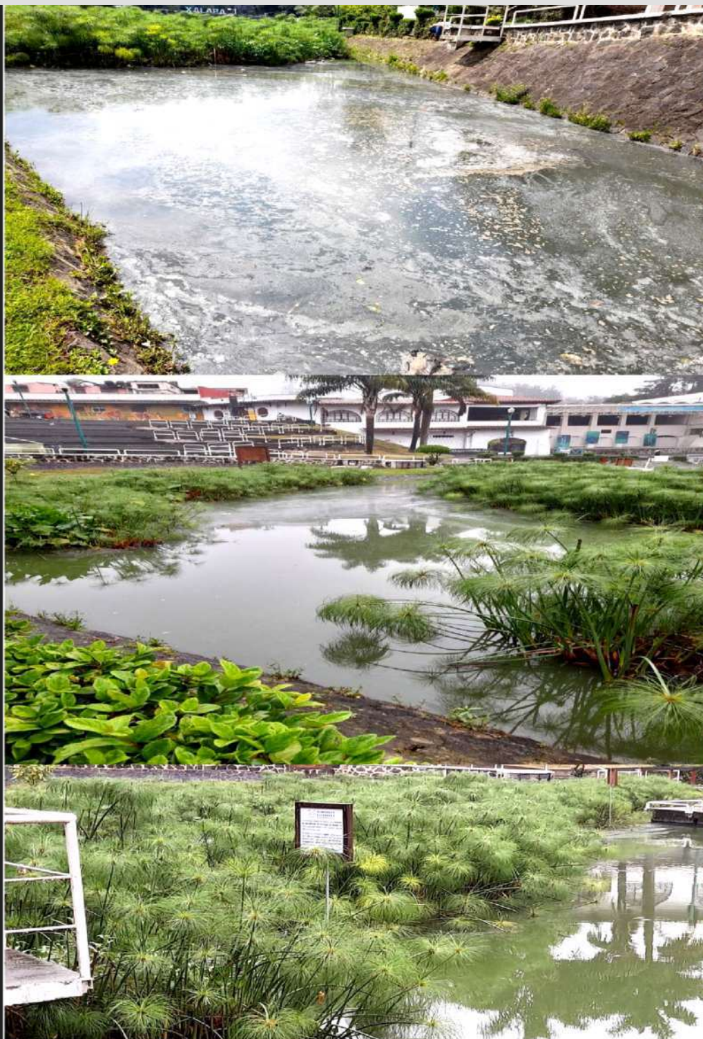
Entra agua al Lago 1 con grasas y coliformes, queda retenida y es degradada por los Humedales Flotantes. A la salida del segundo humedal, ya no se percibe la mancha. Fotografías: Eugenia
