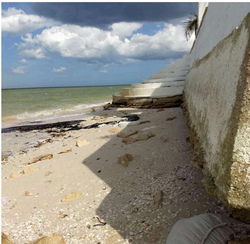
Figura 3. Estructura de una casa construida en una playa de Progreso, Yucatán. Debido a su cercanía al mar y la ausencia de dunas, el oleaje ha removido la arena afectando a la estructura. Fotografía: C. Maximiliano
